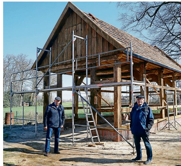
Zusätzliche Ausstellungsfläche: Werner Dullweber (links) und Franz-Josef Göttke vom Bakumer Heimatverein sind glücklich, dass die Scheune neu errichtet wird. Foto: C. Meyer
