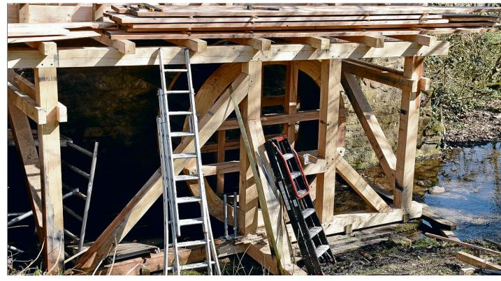
Kompletter Austausch: Bei der Wassermühle Höltermann haben die Mitarbeiter der Firma Vaags unter anderem ein neues Ständerwerk aufgebaut, an dem das ebenfalls neue, aus Stahl und Holz gefertigte Wasserrad aufgehängt ist.
