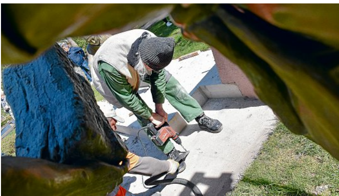
Der Künstler legt beim Aufbau selbst Hand an: Bernd Maro bohrt die Löcher für die Befestigungen in die Bodenplatte.
