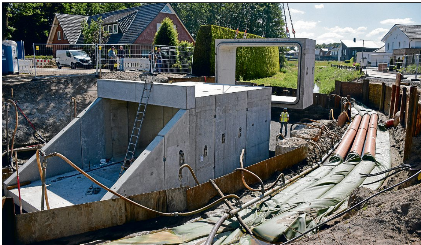
Es geht voran: Die acht Bauteile der Brücke in der Wiek wurden jetzt eingesetzt.
