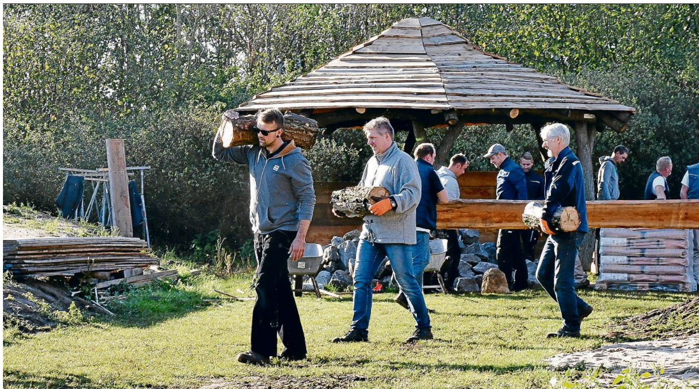
Fleißige Handwerker: Auf dem im Bau befindlichen Naturspielplatz wird zurzeit kräftig zugepackt.
